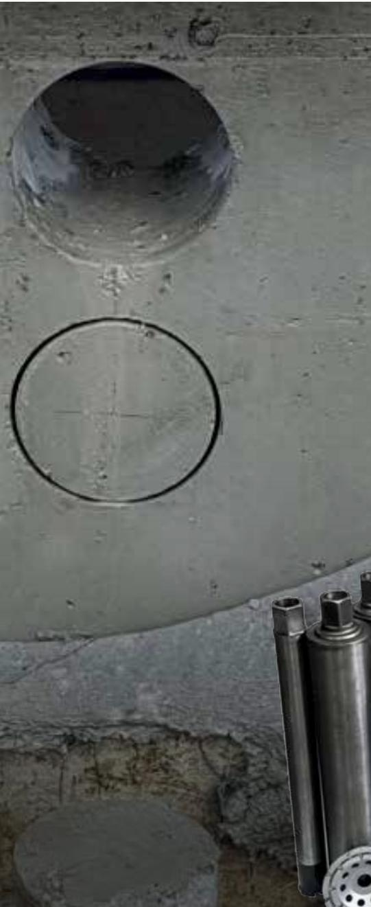
**A**ktuell sind 17 Teams für unserer Kunden unterwegs. Kernbohrungen werden standardmäßig von 16 mm bis 1000 mm in jeglichem Untergrund durchgeführt. Tiefe bzw. instabile Bohrungen werden mit Schraubbohrsystemen verwirklicht. Bohrungen mit einem größeren Durchmesser als 1000 mm werden per Kreissäge durchgeführt.
