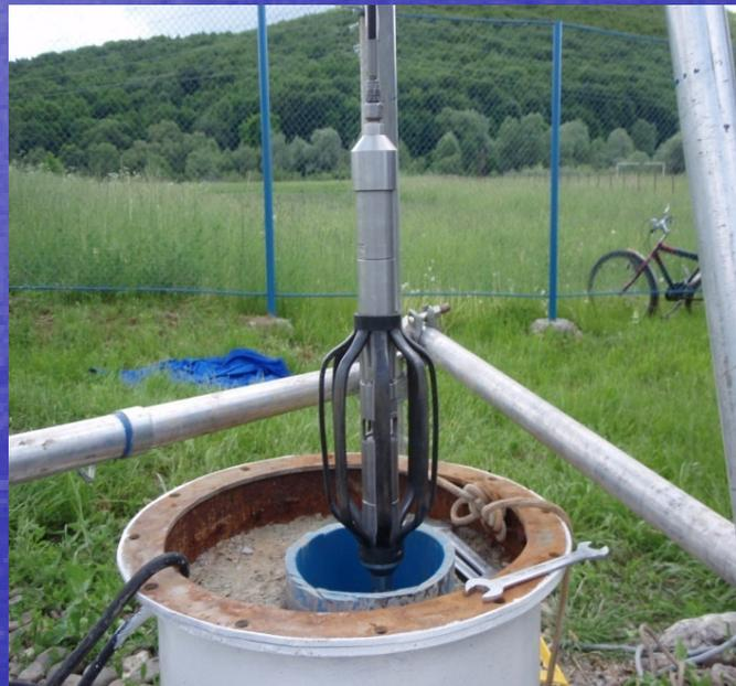
"Pulsen" ist ein hydraulisches Regenerierverfahren, zugelassen lt. DVGW Merkblatt W 130, zur Erhöhung bzw. Wiederherstellung der Ergiebigkeit von Förderbrunnen und Förderbohrungen, der Wiederherstellung der Funktionsfähigkeit von Grundwassermessstellen sowie der Mobilisierung von Schadstoffen im Untergrund basierend auf der schlagartigen Expansion eines hochkomprimierten Gases oder Flüssigkeit.
