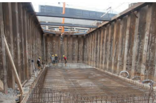
Baugrube eines Fettabscheiders
