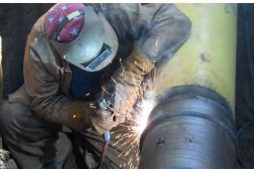
Schweißarbeiten an einer Gasleitung
