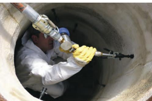
Zementleiminjektion im Niederdruckverfahren
