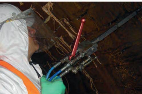
Rissverpressung mittels Harzinjektion
