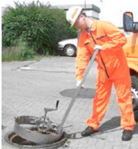
Einsetzen in den Schachtkopf
