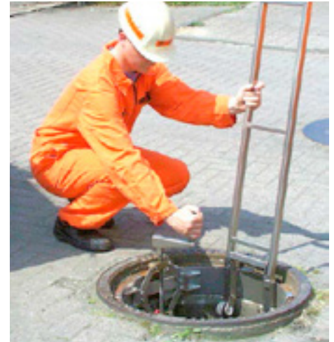
Stufenloses Verspannen der Einstieghilfe
